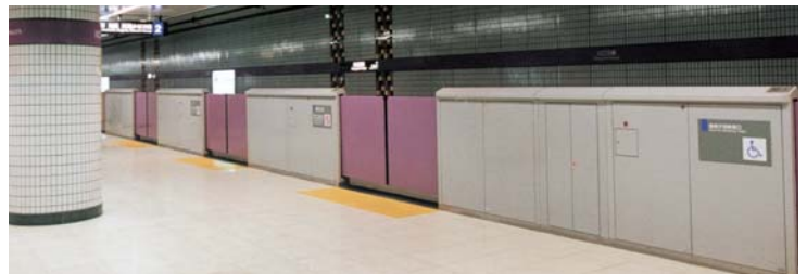
可動柵 埼玉高速鉄道
